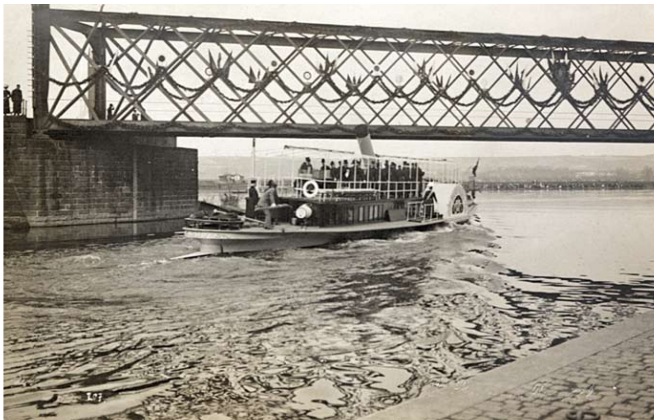
Železniční most přes přístavní rameno převádějící trať Rakouské severozápadní dráhy z Rohanského ostrova do Karlína. Foto 1907, Muzeum hl. m. Prahy
