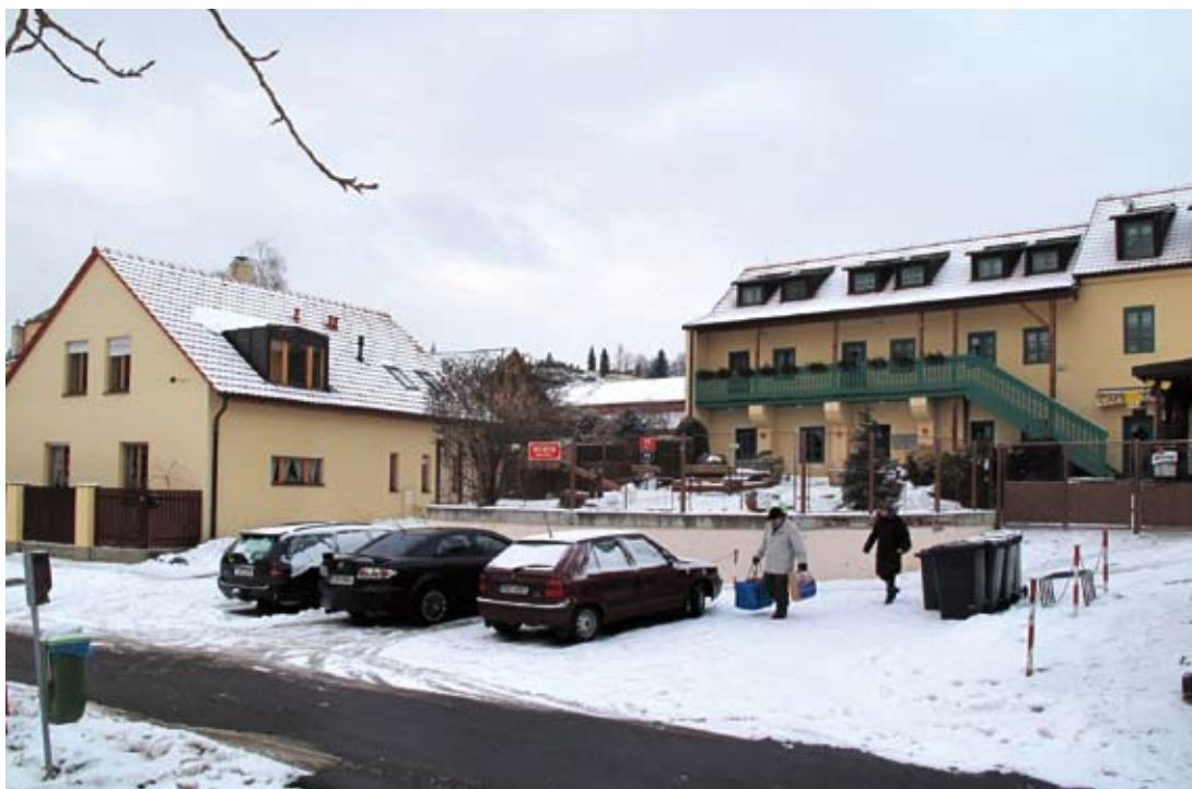
Troja-Rybáře – Dům čp. 20 (s pavlačí) a novostavba na místě staršího domu čp 17. Foto P. Priknerová, prosinec 2010
