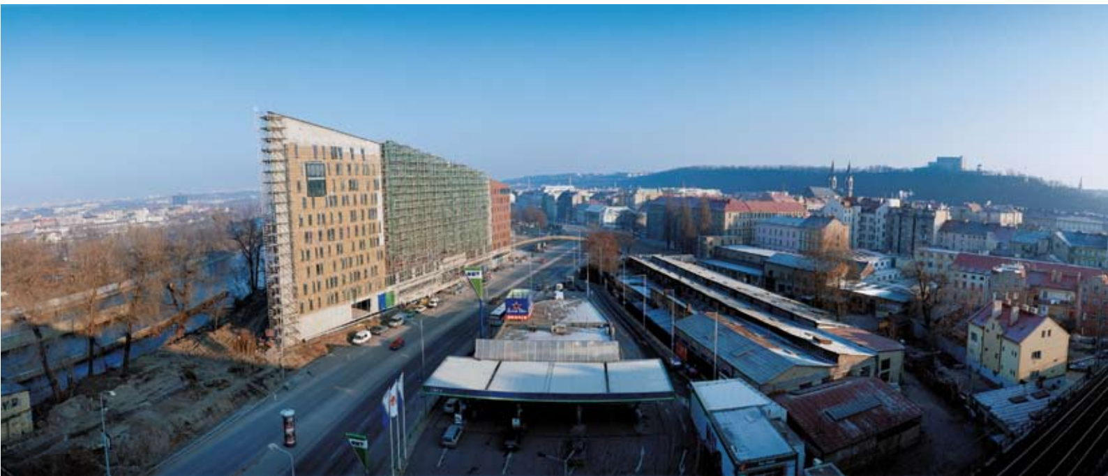
Stavba komplexu budov River City Prague, v popředí budova Danube House, lidově zvaná Titanic. V popředí – mezi Rohanským nábřežím vlevo a Pobřežní ulicí vpravo – dnes již neexistující industriální soubor budov, na jehož místě je právě dokončován administrativní komplex Main Point Karlin. Foto Josef Sředa, prosinec 2002
