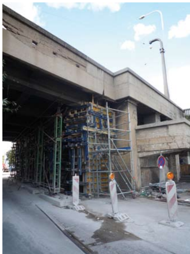
Dlouhodobé provizorní podepření rámové části Libeňského mostu. Foto V. Jandáček, 2010
