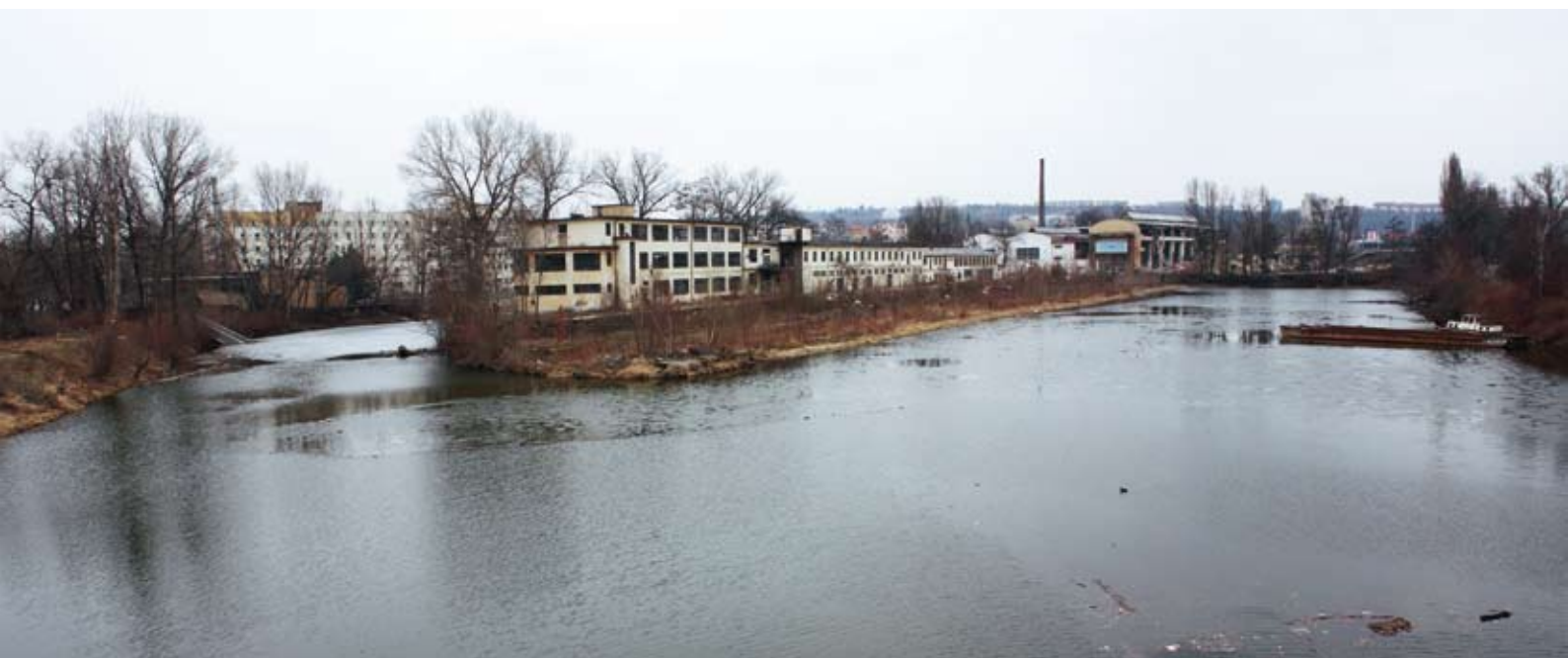
Ztichlý bazén Českých loděnic v pohledu od ústí Rokytky těsně před demolicí budov. Foto Zdeněk Lefan, březen 2010
