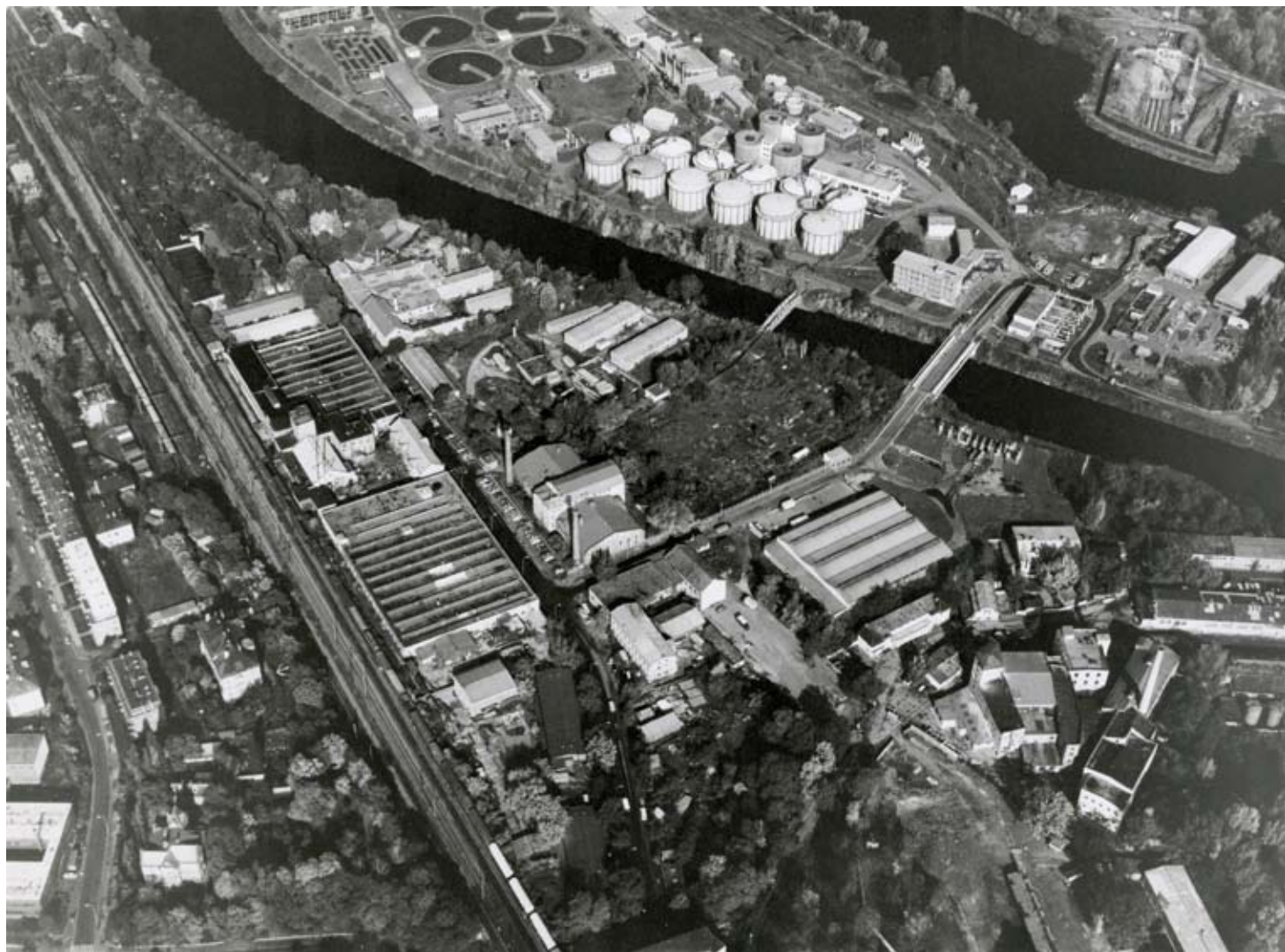
Letecký pohled na okolí plavebního kanálu v okolí Papírenské ulice a zařízení Staré kanalizační čistírny i nové čistírny na Císařském ostrově. Foto K. Wartha, kolem 1990, Muzeum hlav města Prahy
