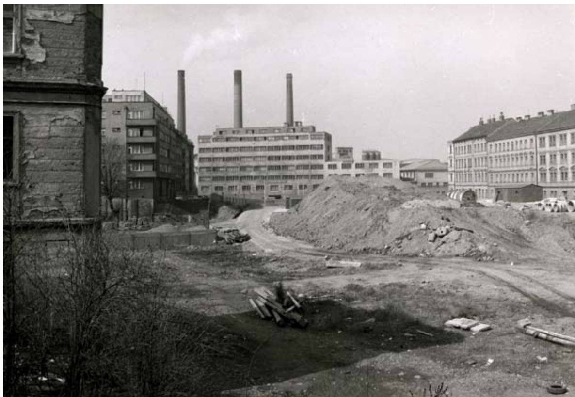
Bourání starých Holešovic. Pohled do prostoru mezi ulicemi U Elektrárny a Arnoštovskou. Funkcionalistický blok domů vlevo byl zachován, domy vpravo zbořeny. Na jejich místě dnes frekventovaná ulice Vrbenského.
