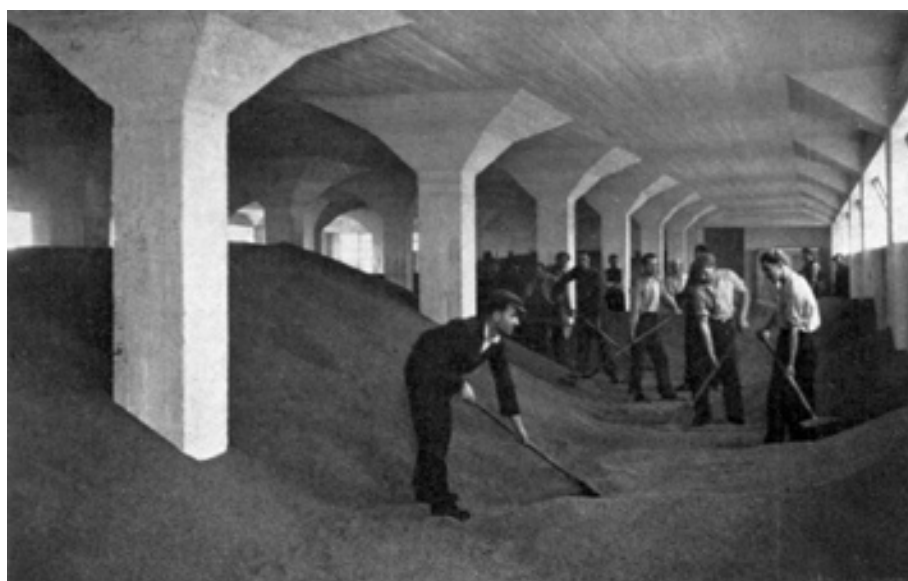
Nákladové nádraží Žižkov, 1936, repro z: Arnošt Katz, Nákladové nádraží Praha-Žižkov, Praha 1937
