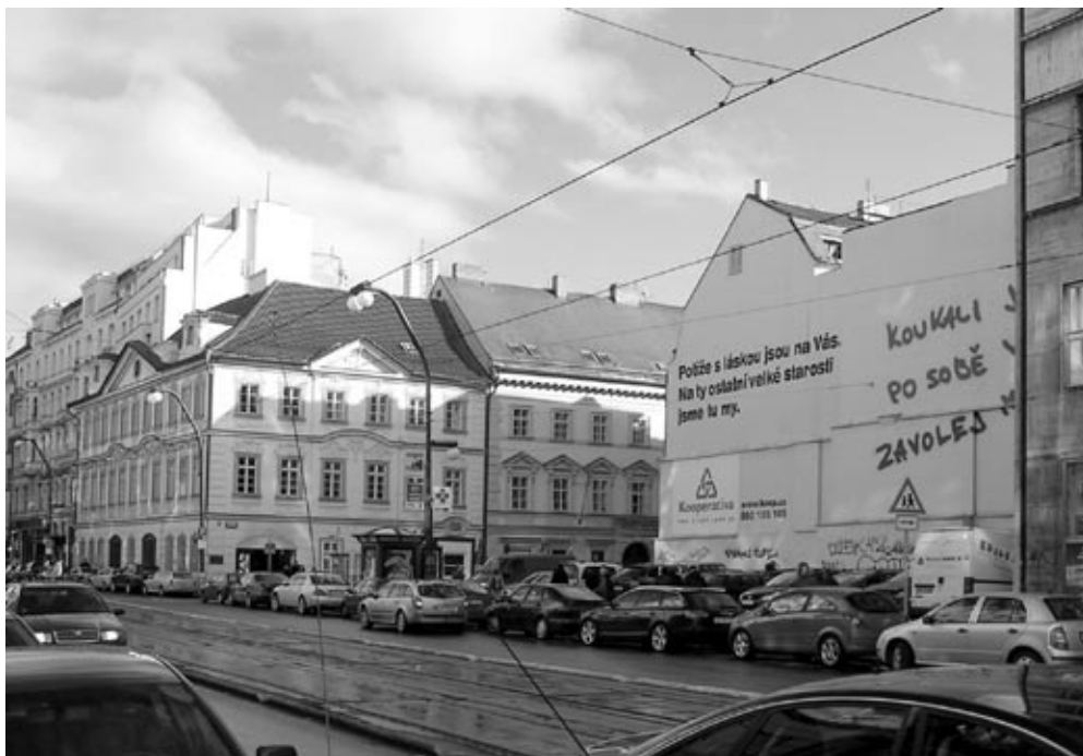
Proluka na nároží Národní třídy se nachází ve velmi složitém urbanistickém kontextu. Z každé strany bude totiž novostavba navazovat na zcela odlišné historické prostředí. Foto R. Biegel, leden 2007
