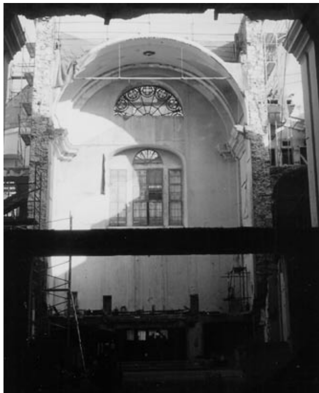
Interiér kostela po demolici transeptu a části závěru. Foto M. Patrný, 2000
