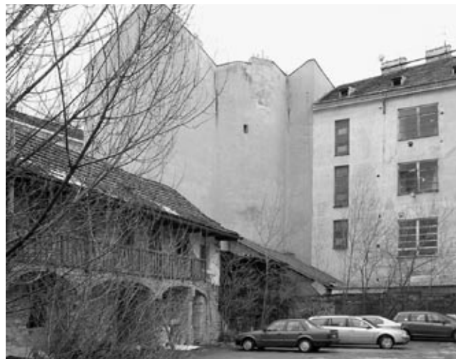
Jihovýchodní roh dvora bloku mezi Vítěznou a Újezdem. Zleva nízké stavení z konce 18. století, nároží domu čp. 442-III a dvorní průčelí domu čp. 534-III; nároží i dvorní fasáda má být zakryta novým křídlem. Foto R. Biegel, leden 2007
