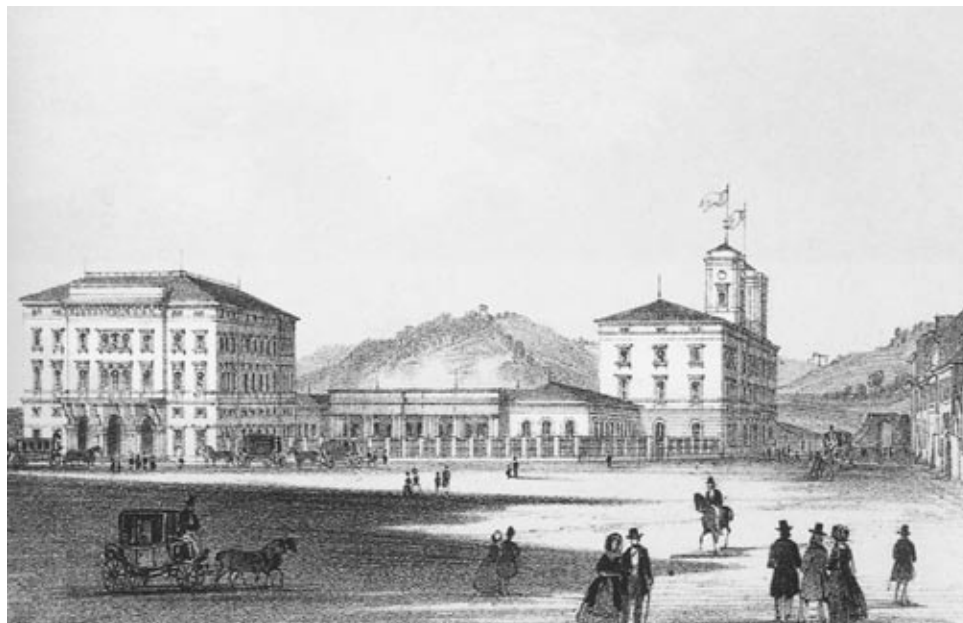
Nádraží Státní dráhy od Havlíčkovy ulice těsně po dokončení. Litografie z roku 1845. Muzeum hl. m. Prahy
