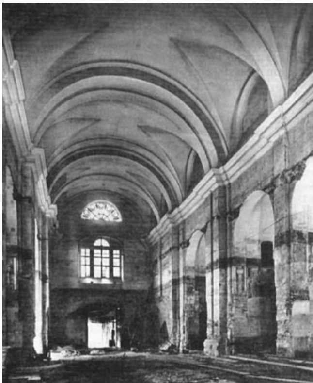
Interiér bývalého kostela po odstranění vestavěných pater, pohled k presbytáři. Foto 1940
