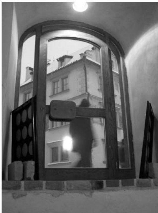
Do renesanční síně se bude vcházet přímo z chodníku Mostecké ulice po dřevěném schodišti, které v době pořízení tohoto snímku dosud nebylo instalováno.
