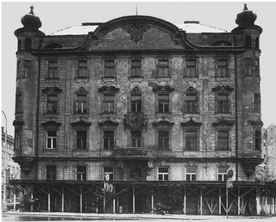
2. Nové Město. Hlavní průčelí neobarokního Špačkova domu čp. 1216, zbořeného roku 1993, v Klimentské ulici. Foto 1993
