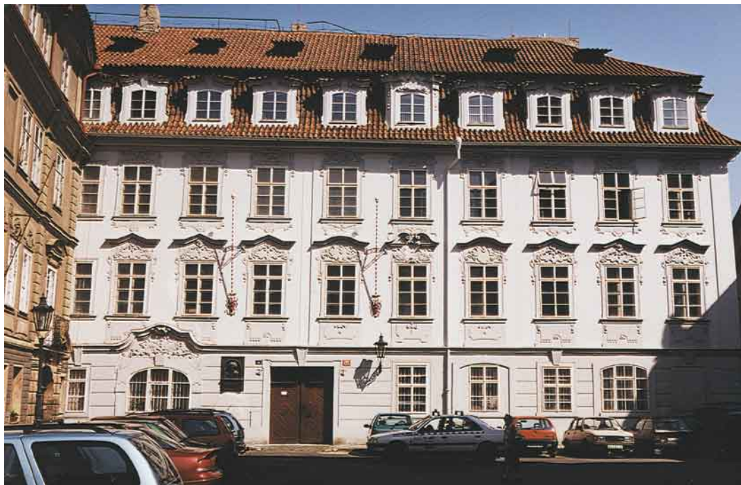
1. Malá Strana, dům čp. 285 U Bílého jednorožce v Lázeňské ulici. Stav před přestavbou, při které byla vložena půdní vestavba do druhé etáže mansardového krovu.
