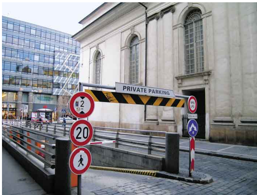
5.– 6. Nové Město, Panská ulice. Nájezdová rampa do garáží pod palácem Myslbek. Foto K. Hanzlíková, 2005
