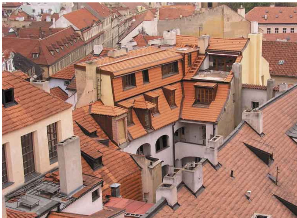
4. Některé půdní vestavby jako by ilustrovaly falešnou iluzi o tom, že v místech, kam nelze snadno dohlédnout, se může povolit cokoli. Pohled z vnějšího ochozu nad lodí chrámu sv. Mikuláše na Malé Straně.
