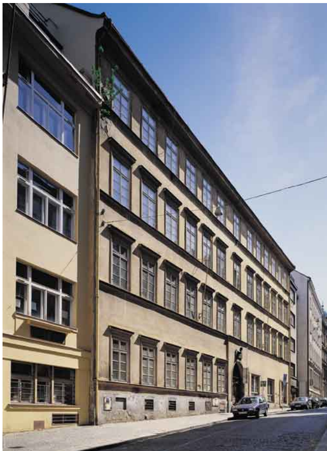
3. Nové Město, Dům čp. 1325 ve Školské ulici, namísto plánované demolice jej čeká radikální přestavba.
