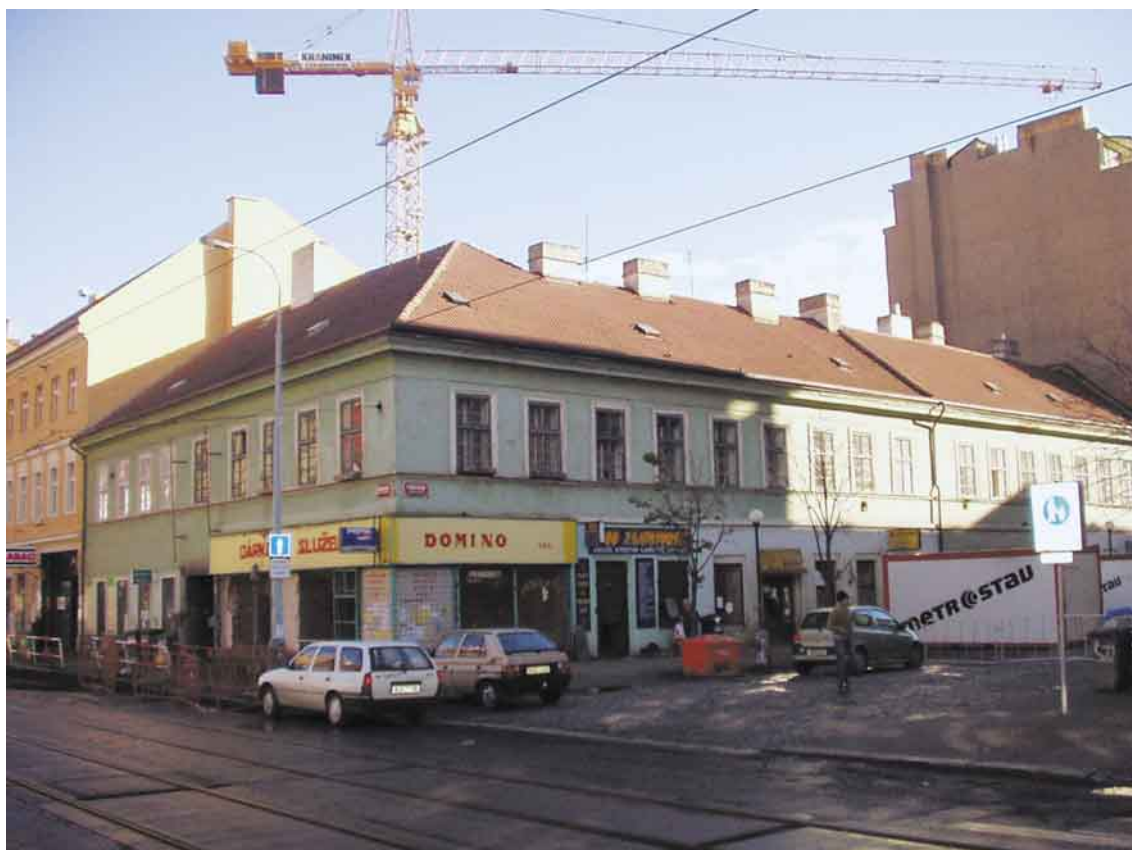
4. Karlín, dům čp. 110 na nároží Thámovy a Sokolovské ulice, zbořen 2003.
