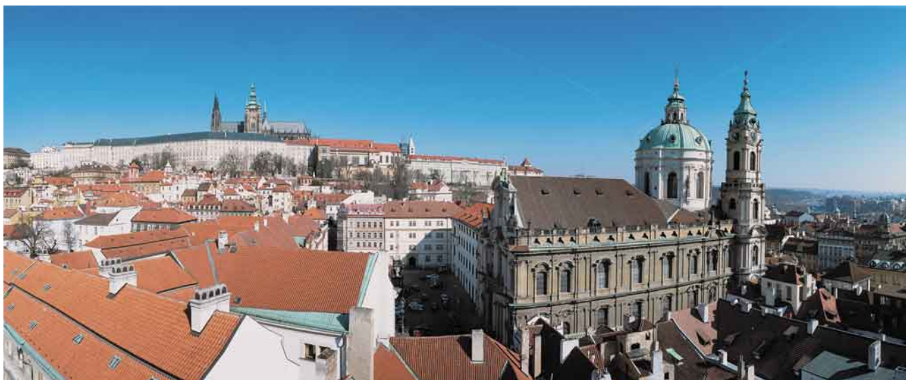
1. Stavební činnost v historickém jádru města musí být podřízena nejprísnejším regulativům. Panorama Malé Strany a Hradčan. Foto J. Středa, březen 2003
