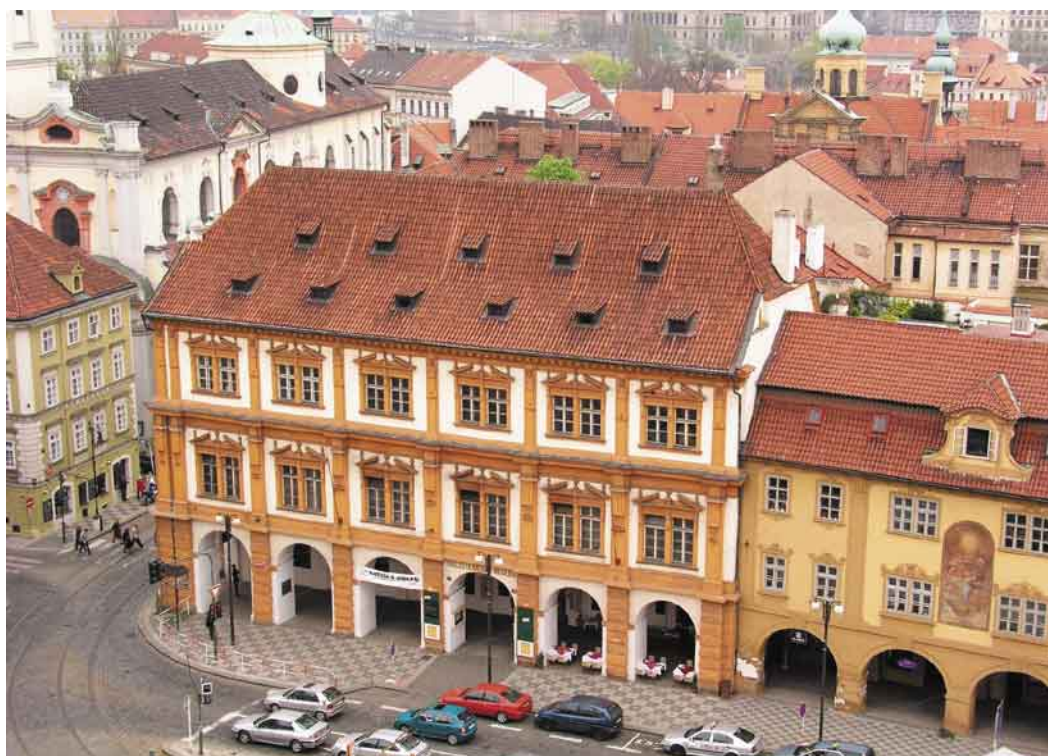
13. Malá Strana, bývalá Malostranská radnice na Malostranském náměstí. V souvislosti s plánovanou rekonstrukcí budovy hrozí též utilitární půdní vestavba.
