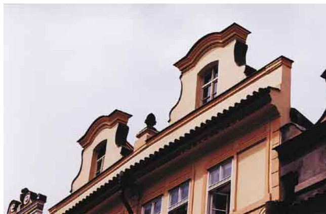
5. Malá Strana, ilustrační snímek koruny štítu kryté plechem. Ve srovnání s prejzy, taškami či omítkou působí černá linka oplechování turdě. Krása malostranské střechy je pryč.
