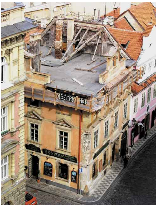
14. Malá Strana, dům U Bílé kuželky čp. 66 v Míšeňské ulici po demolici barokního krovu během podzimu 2003.
