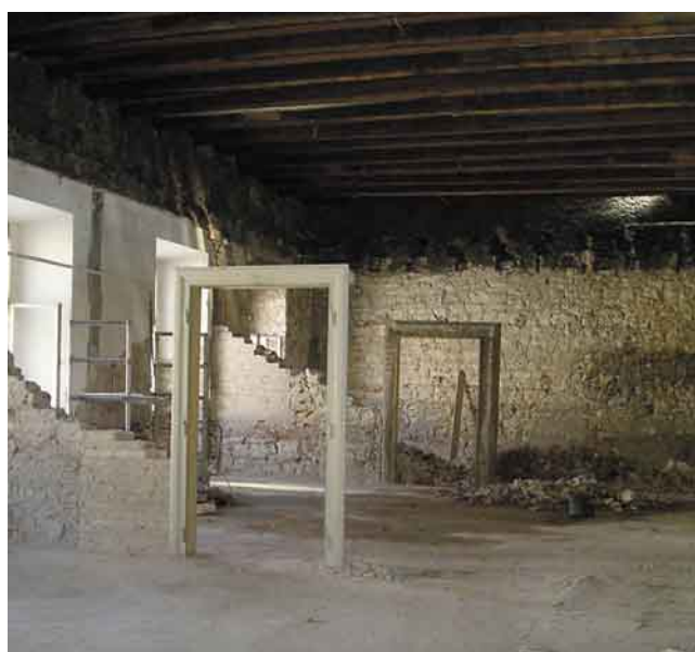
14. Staré Město, paláce Hrobčických a Wimmerův v Rytířské ulici. Piano nobile obou paláců připravené na zahájení novodobé vestavby. Foto J. Veselý, 2005
