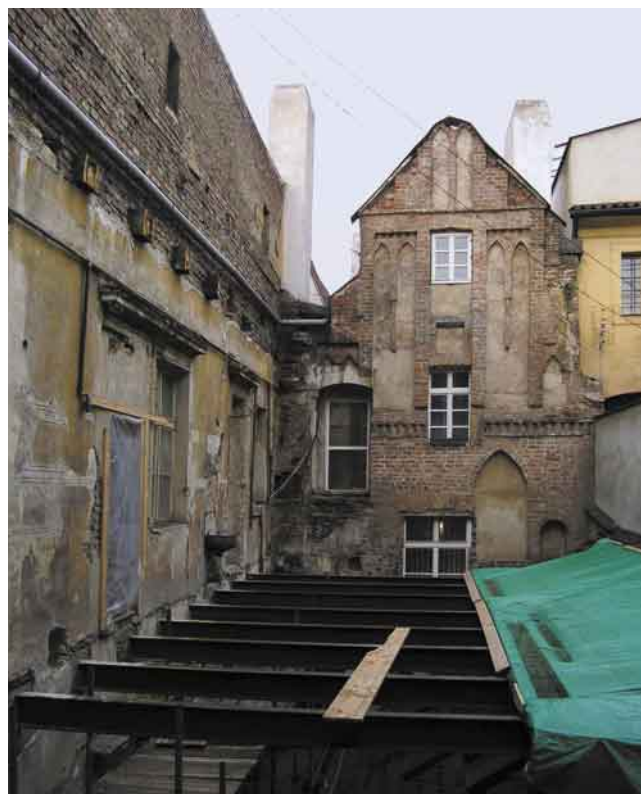
9. Staré Město. Nádvoří domu čp. 478 na Staroměstském náměstí skrývá kromě skvostné gotické cihelné fasády a zbytků sgrafitových omítek i doklad nevšedního barbarství majitele. V popředí ocelové traverzy nového přestropení dvora.
