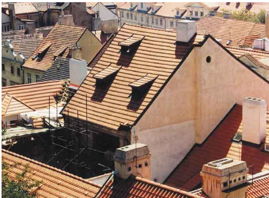
11. Malá Strana, snímek ilustruje dopad užití plechových závětrných lišt u štítů. Zejména, použije-li se měděný plech, vytvoří závětrná lišta v obrazu historických střech tvrdou černou linku.
