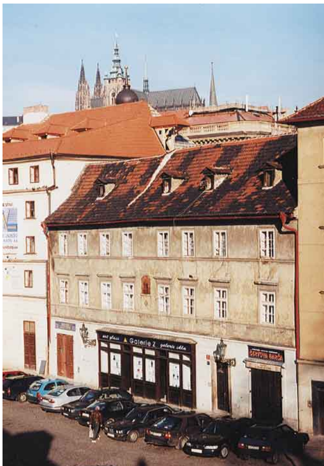
10. Malá Strana, snímek ilustruje hodnotu patiny střešní krytiny i význam drobných architektonických detailů jako jsou vikýře bez oplechování či živá linka omítané protipožární zdi.
