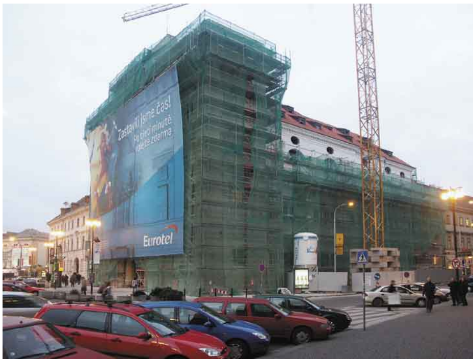
6. Nové Město. Palác U Hybernů na náměstí Republiky, přestavba někdejšího kostela na muzikálové divadlo. Na zbrusu nové střeše se objevují i nové vikýře. Foto J. Veselý, 2005
