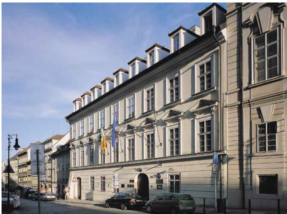
16. Malá Strana, Wratislavský palác čp. 366 na Tržišti. Jedna z nebrutálnějších realizací půdní vestavby na konci 20. století na Malé Straně.
