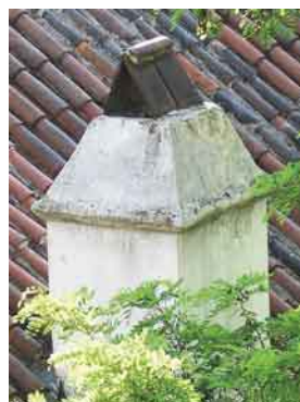
19. Malá Strana, ilustrační foto typického zastřešení komínů, v tomto případě na komínu Ledeburského paláce.
