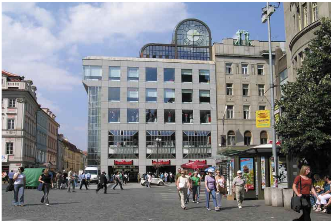
1. Staré Město. Budova ČKD na Můstku z let 1976–1983 je jednou z mála zdařilých novostaveb v historickém prostředí vzniklých v minulém režimu. Foto J. Bečka, 2005
