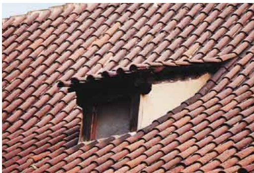
2. Staré Město, palác Platýž čp. 416, příklad typického větracího vikýřku. Základem jeho konstrukce je nosné truhlářské čelo, boky jsou omítané a vikýř nemá plechové závětrné lišty ani jiné klempířské doplňky. V této podobě tradičního vikýře bylo dosaženo dokonalosti technické i výtvarné.
