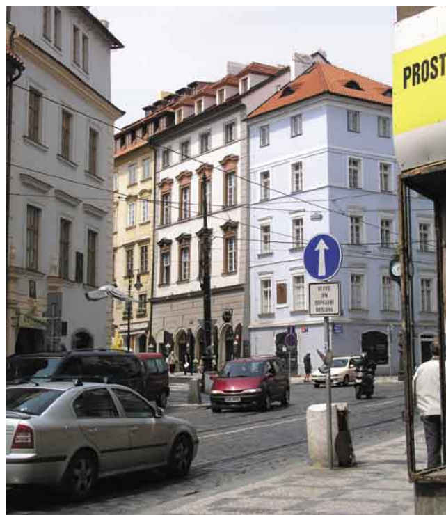
17. Malá Strana, pohled do ústí Tržiště z Karmelitské ulice směrem k domu u Glaubiců, jehož střecha je po přestavbě posázena vikýři půdní vestavby.
