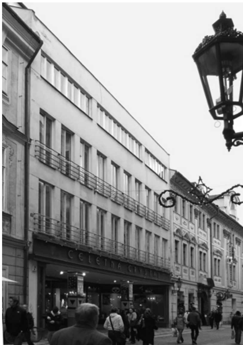
Hlavní průčelí domu v Celetné ulici.
