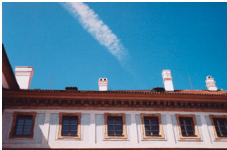
7. Nad Toskánským palácem jsou komíny odlišných tvarů.
