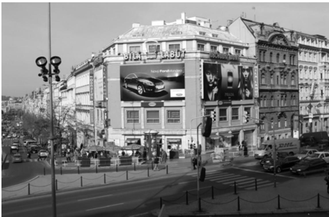
Bývalý Dům potravin dnes – věšák na reklamu, která jakoby úmyslně zakrývala jeho fasádu, aby snad někoho nenapadlo, že jde o architekturu hodnou ochrany.
