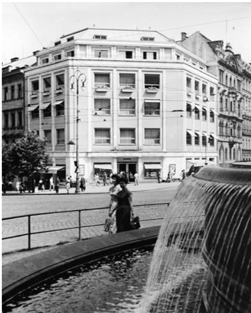
Dům potravin po svém dokončení v roce 1957. Foto Muzeum hlav. města Prahy
