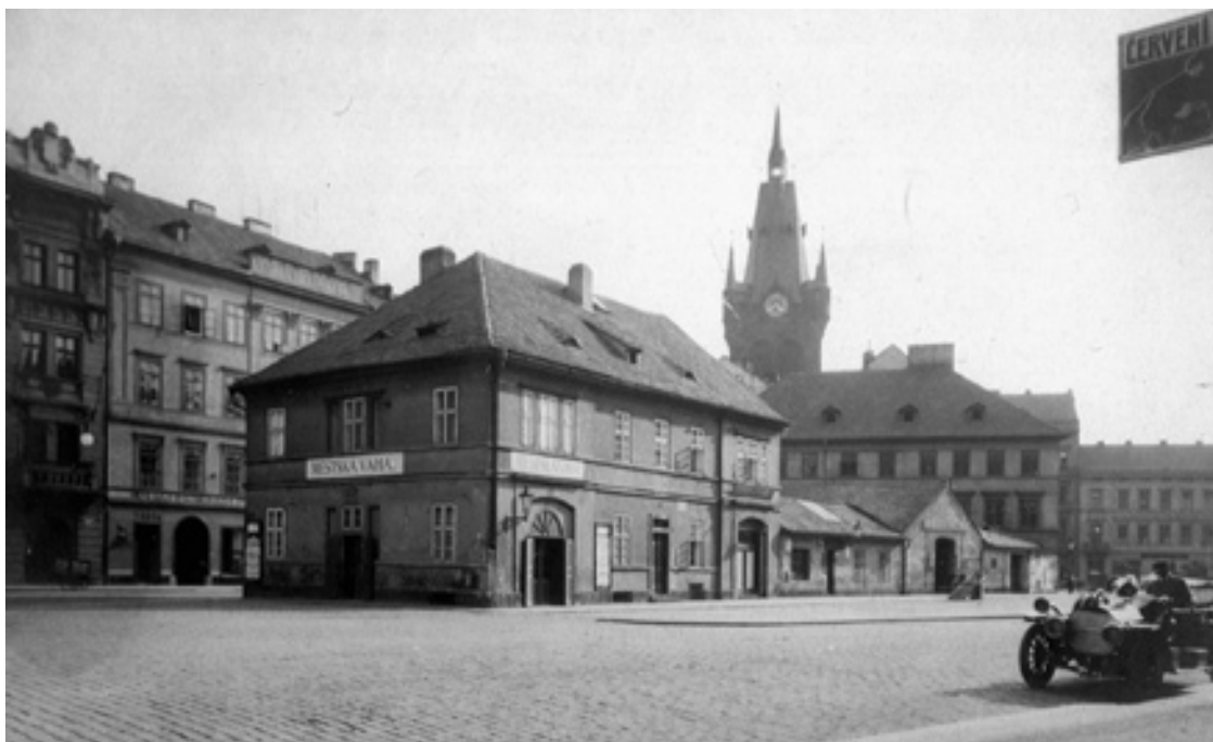
Senovážné nám. před stavbou Cukerného paláce. V pozadí Jindřišská zvonice.
