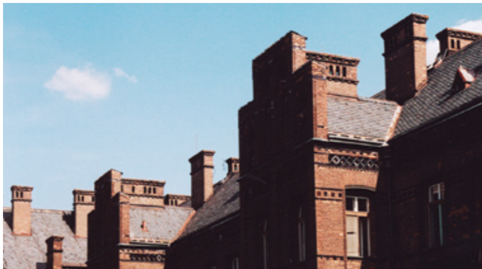
11. Střechy porodnice v Apolinářské ulici se „ježí“ komíny různého provedení.
