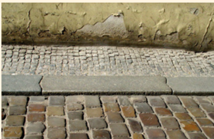
Běžné masivní žulové obrubníky byly na nárožích vždy speciálně tvarovány, aby přesně kopírovaly průběh okraje chodníku.
