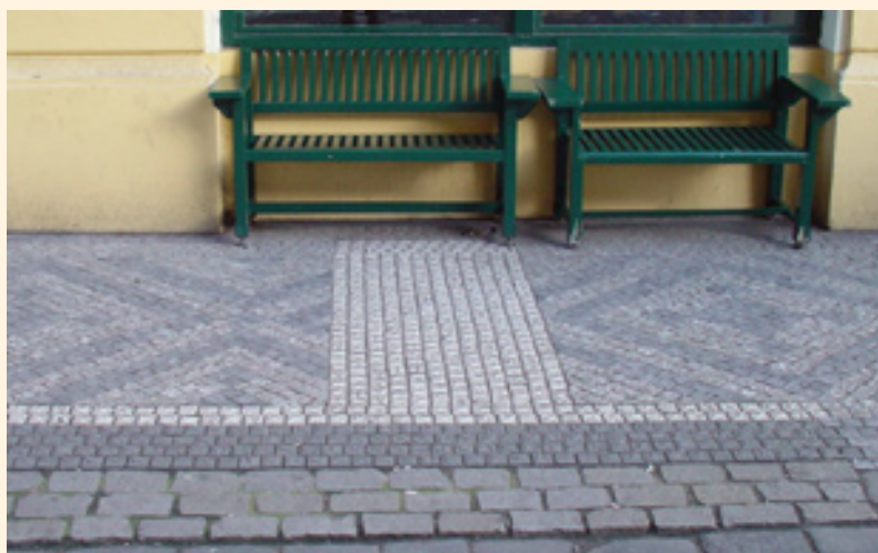
Nesprávné rozvržení vzoru, k němuž došlo při pokládání dlažby. Dláždilo se z protilehlých stran a vzor se uprostřed „nesešel“. Také samotný vzor je proveden nesprávně, středový čtverec má být větší.
