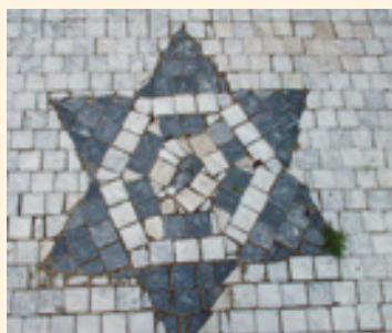
Ukázka nevhodnosti řezané mozaiky k provedení jemnějších detailů.
