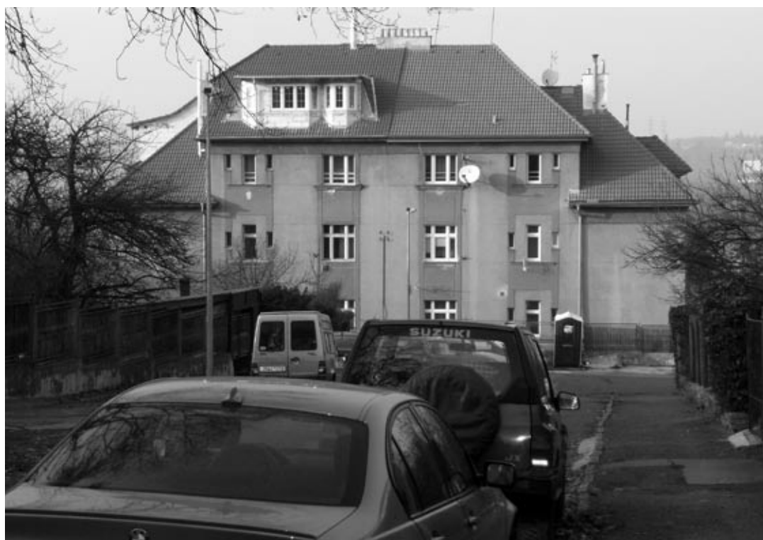
7. Ulice Nad Zámečkem, dům 62/380, půdní vestavba, na které je porušena symetrie valbové střechy dvojdomu, nevhodná forma zastřešení i osmibokých parapetů oken.
