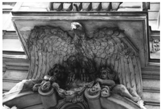
12. Z Lipové ulice je i tento statný orel
