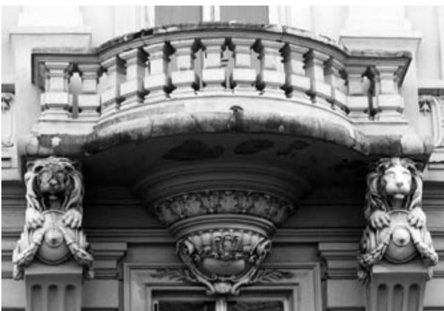
11. V Lipové ulici jsou ve funkci atlantů dva malí lvi
