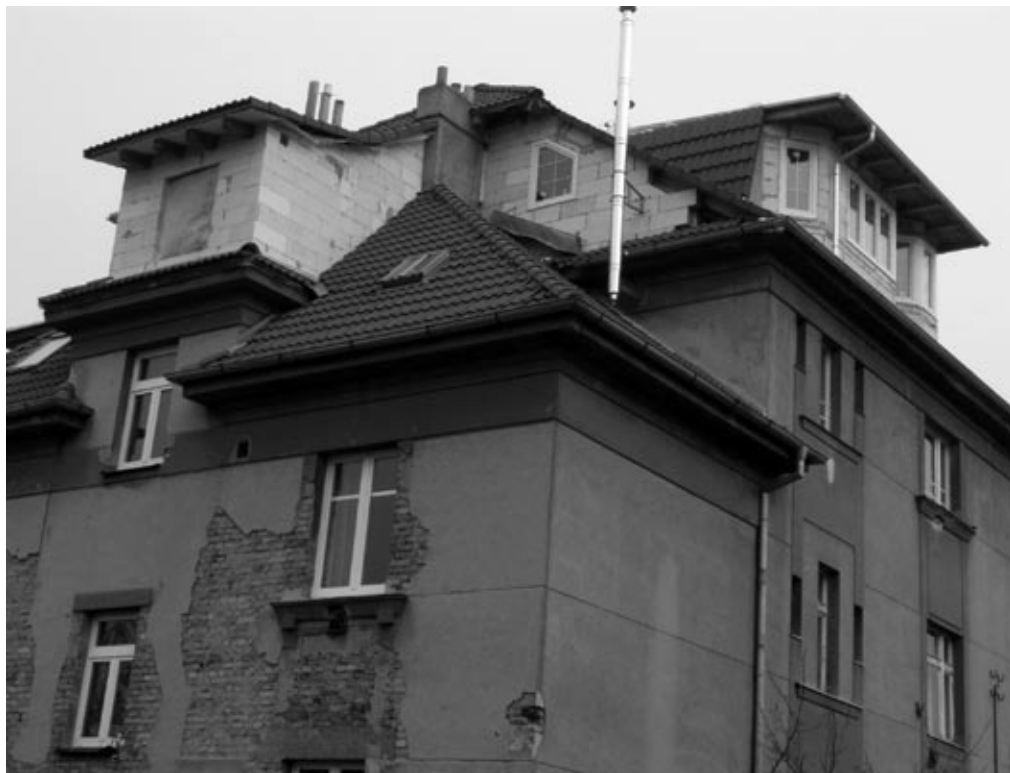
8. Ulice Nad Zámečkem, dům 62/380, detaily půdní vestavby
