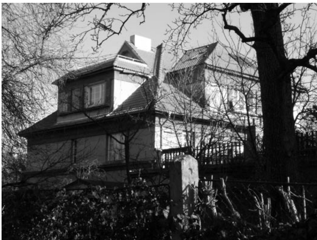
9. Ulice U Lesíka, dům 8/360, zrušena původní valba střechy, na jejím místě střešní terasa
