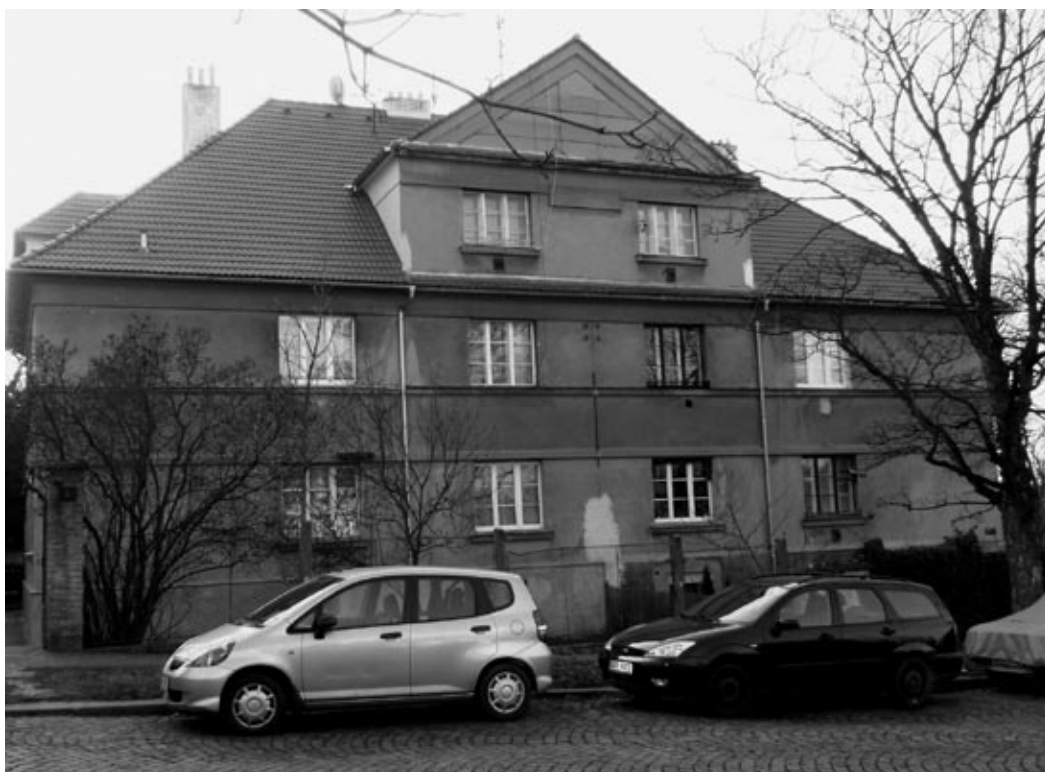
6. Drobné necitlivé úpravy domů: na jedné fasádě se střídají původní dřevěná okna s plastovými, bílý nátěr oken s hnědým nátěrem.
