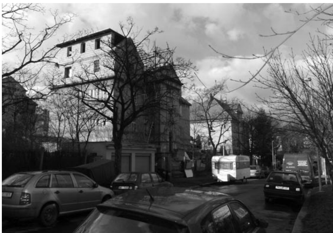
11. Ulice Nad Zámečkem 39/385, „půdní mezonetová vestavba“: na místě valbové střechy je realizována nad hlavní římsou stavba jakéhosi podivného domu s převýšením původního hřebene střechy
