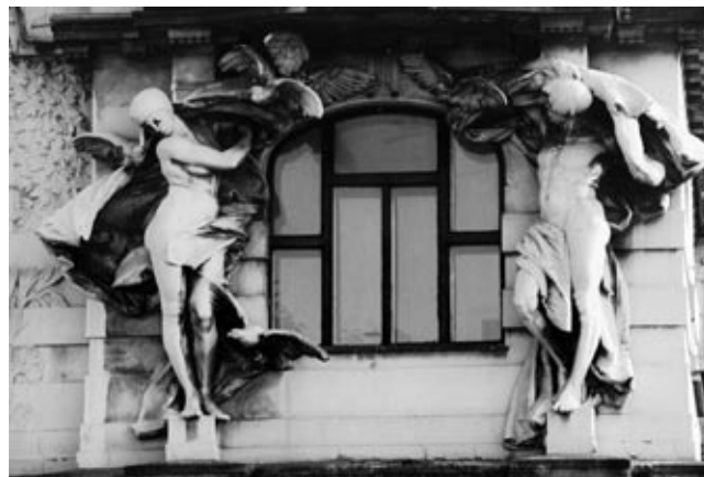
4. Karyatida s atlantem pod levým balkonem nad původním vchodem na Hlavní nádraží
