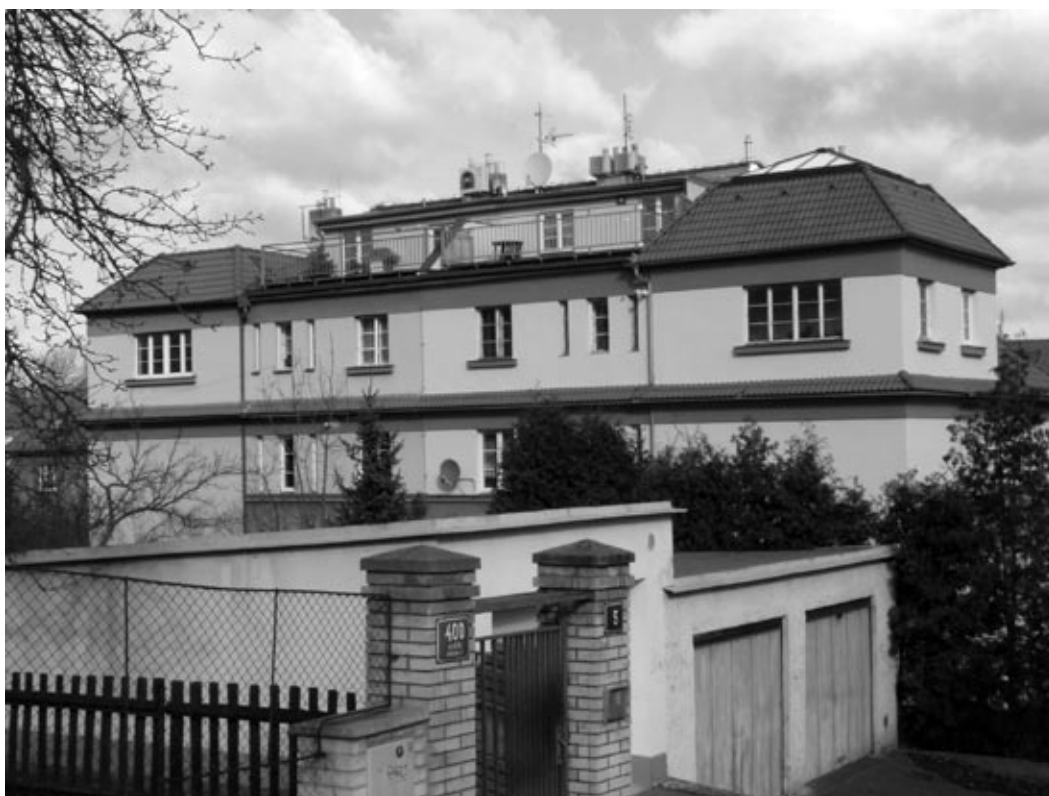
10. Ulice V Stráni 7/387, nástavba domu až do výše původního hřebene střechy
