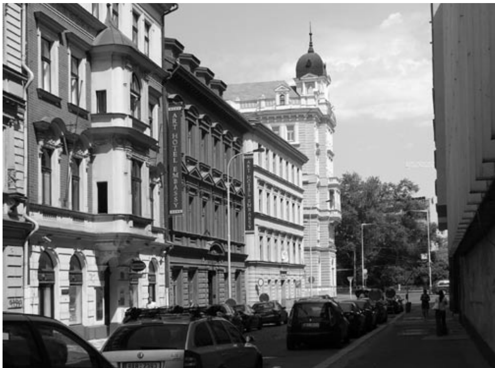
Průčelí domu čp. 1166 v kontextu Petřské ulice
