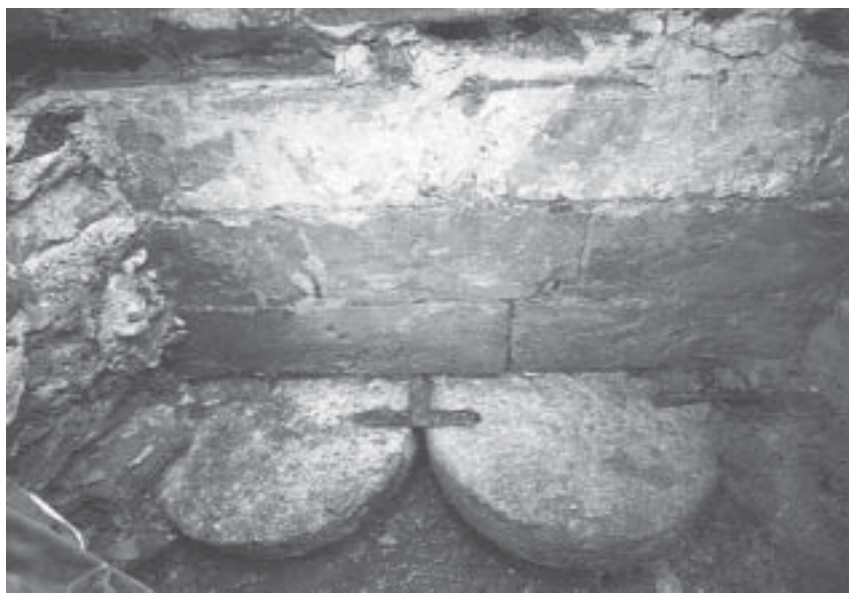
Průzkumná sonda u pilíře č. 9 s mlýnskými kameny tvořícími základovou spáru tohoto pilíře. Foto z průvodní zprávy firmy Mott MacDonald Praha, spol. s r.o.
