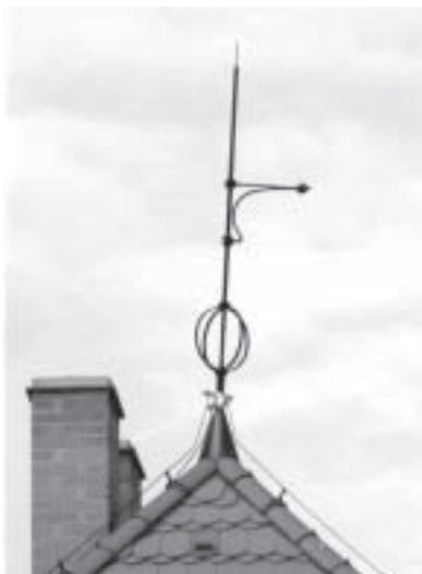
12. Střechy objektu Obchodní akademie v Bubenči hýří plechovými korouhvičkami
