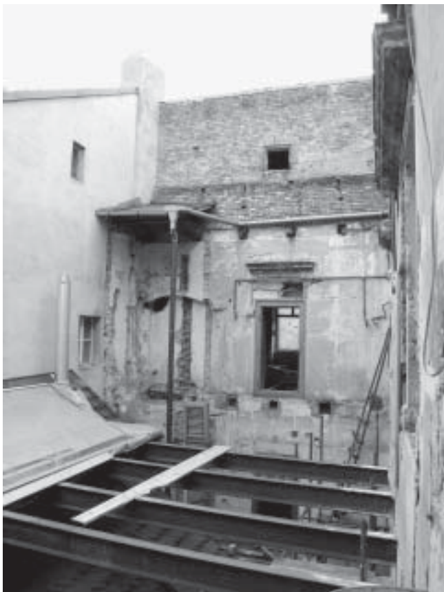
Nádvoří domu čp. 478 po odstranění nežádoucích historických prvků. Foto L. Holá
