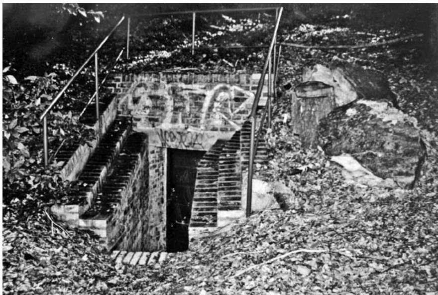
6. Vstup do jedné z jímacích štol ve Střešovicích v pískovcovém zalesněném masivu mezi ulicemi Na Petřínách a Pod Novým lesem
