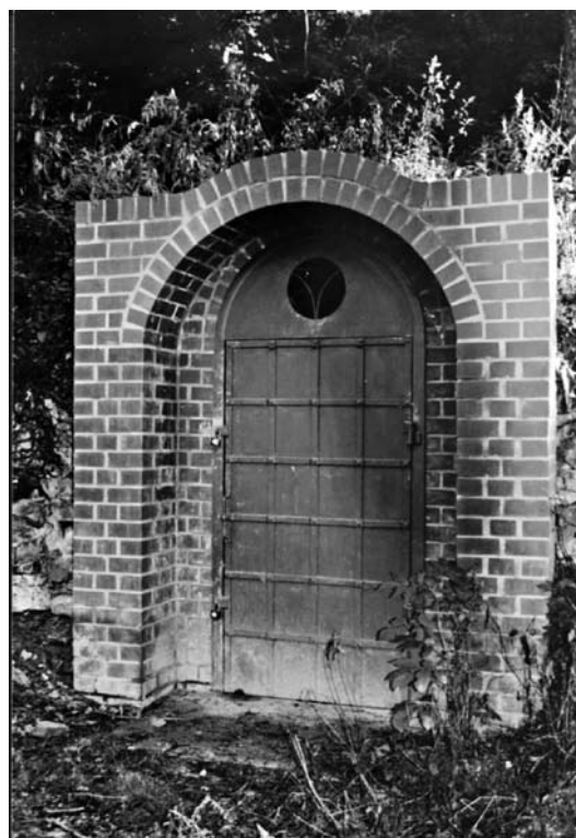
7. Pohled na vstup do jímací štolky upravené pro současný odběr užitkové vody pro Pražský hrad
