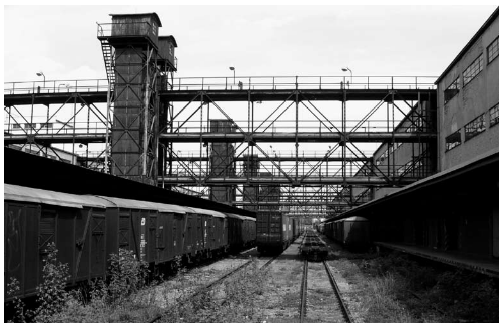
Střední rampa, výtahové věže a lávky
