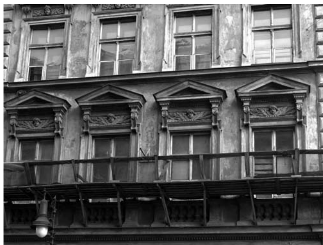
Detail oken na vedlejší fasádě do Kaprovy ulice
