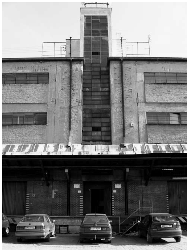
Detail fasády v současném stavu
