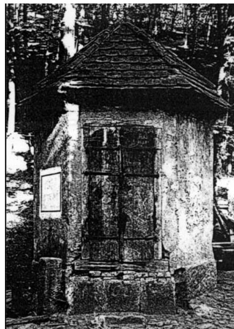
2. Původní stavba studničního domku Světlička
