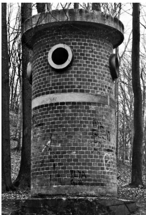
3. Současná stavba vodárenského objektu nad studánkou Světluška
