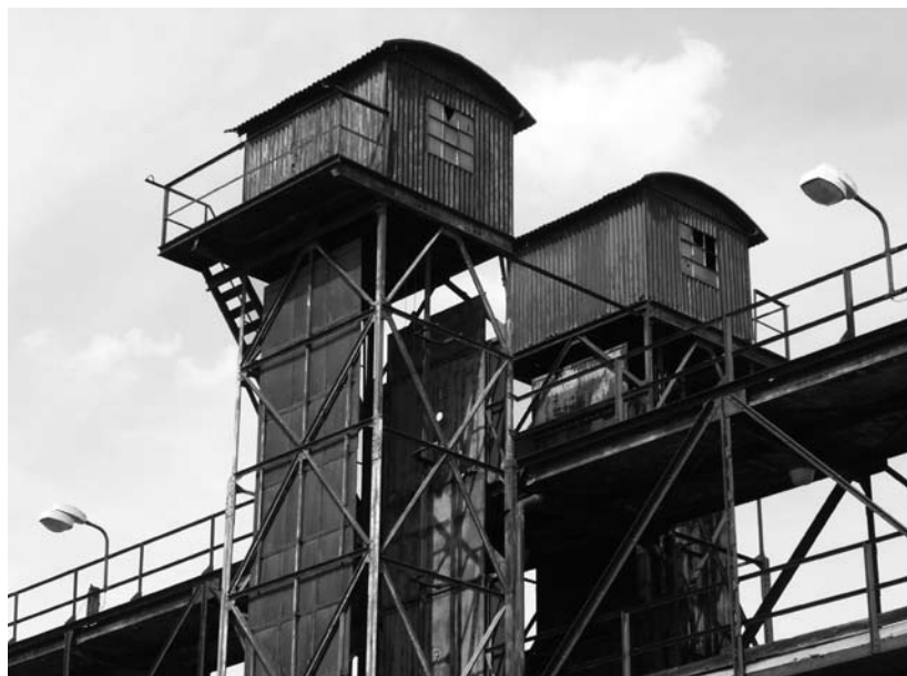
Detail dvojice výtahových věží
