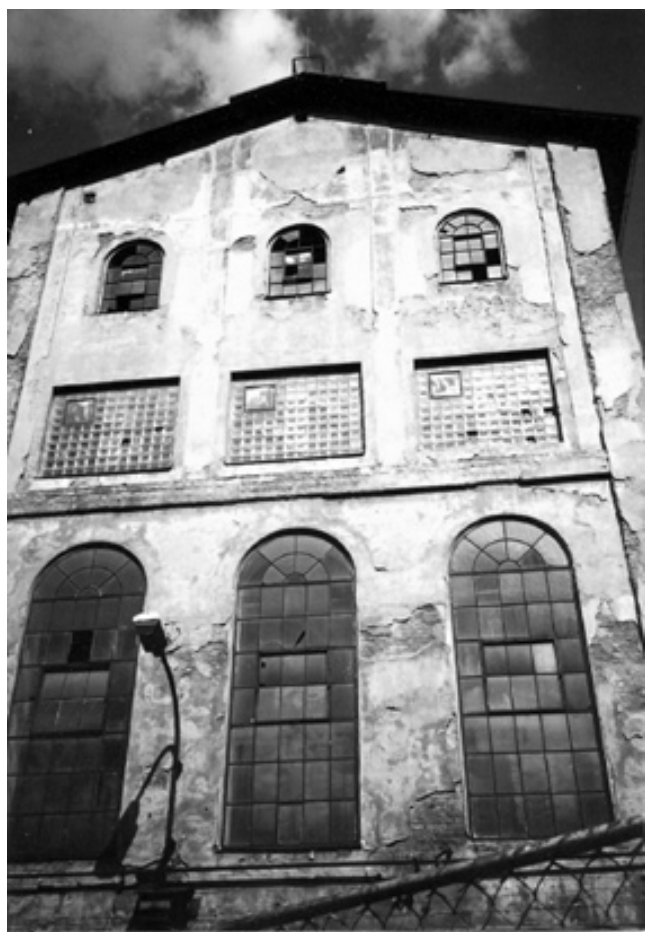
Průčelí budovy rafinerie. Foto Tomáš Šenberger, 2002
