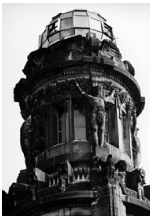
11. Podpory korun věží Hlavního nádraží byly dodatečně zahaleny.
