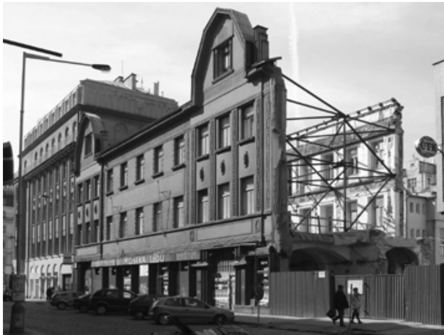
Dům čp. 920 (původně Pražská akciová tiskárna) v Opletalově ulici. Majiteli bylo v roce 2006 povoleno ubourat dvorní části objektu, avšak uliční část s původní fasádou měla být zachována vzhledem k památkové ochraně budovy. V únoru 2008 však Ministerstvo kultury na žádost majitele z objektu památkovou ochranu sejmulo, neboť zbylé torzo již hodnoty, pro které byla budova v roce 2002 za památku zapsána, údajně nenaplnuje. Dalším krokem majitele bude nepochybně žádost o demolici. Exemplární příklad aplikace salámové metody pro uvolnění cenné parcely! Foto K. Bečková, březen 2008
