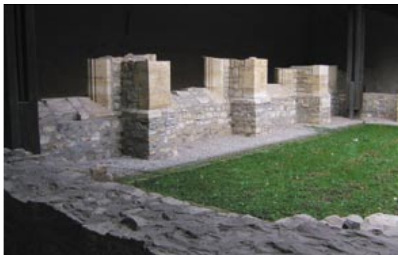
Obr. 9. Ambit kláštera minoritů při kostele sv. Františka na Františku po náznakové rekonstrukci na počátku 90. let 20. století podle projektu SÚRPMO (arch. Kuncy a Hlavatého).
