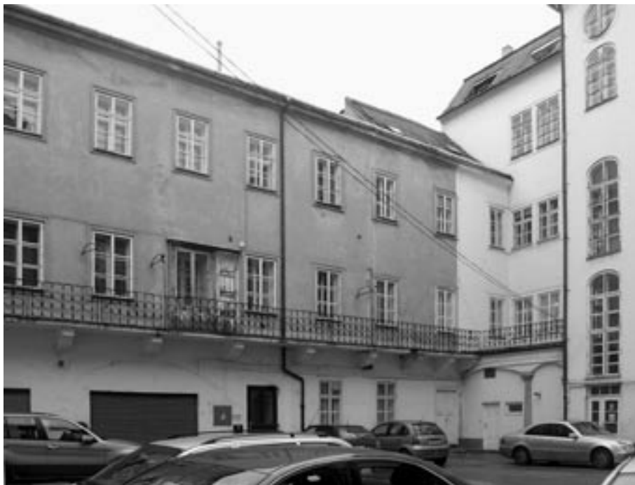
Pravé dvorní křídlo Schönkirchovského paláce a část dvorního traktu uliční budovy. Foto V. Jandáček, leden 2007
