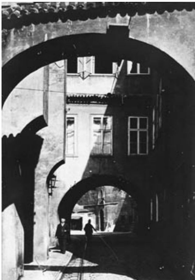
Zato jsme měli zvláštnost skutečně mimořádnou: vzdušný můstek, jenž spojoval bývalý palác s kostelem sv. Tomáše. Byl dosti prostorný, aby se do něho vešla celá školní třída s lavicemi...
