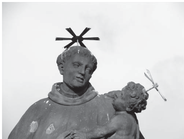
III) Svatozář sv. Antonína byla v r. 1966 rekonstruována v mědi s pozlacením (1). Rekonstrukce nimbů u sv. Antonína i u Ježíška proběhla v r. 1974 (2). V r. 1980 byly opět doplněny obě chybějící svatozáře (2).
