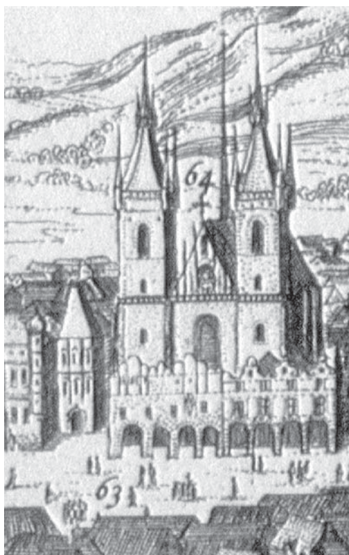
Gotická podoba domu U Kamenného zvonu na Sadelerově prospektu z roku 1606.
