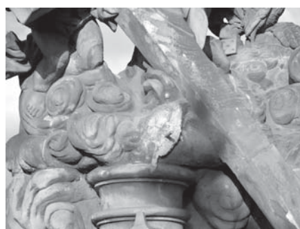
II) Na sloupu s nástroji Kristova utrpení bylo původně popsáno andílka, které dnes chybí. – Vpravo detail původního stavu.
